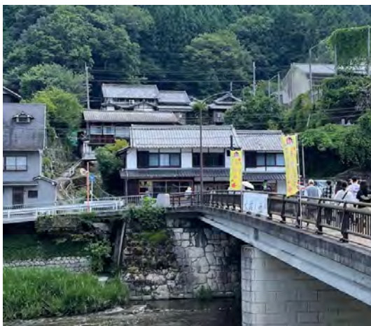
河對岸端點處設置 Office Camp
